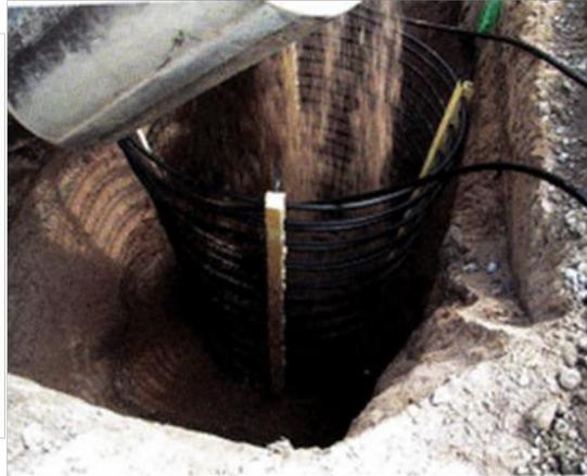
Abbildung 27 Prinzip (links) und Einbau (rechts) eines Erdwärmekorbs[10]
