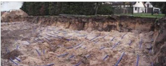
Abbildung 24 Bau einer Flächenkollektorfläche [10]
