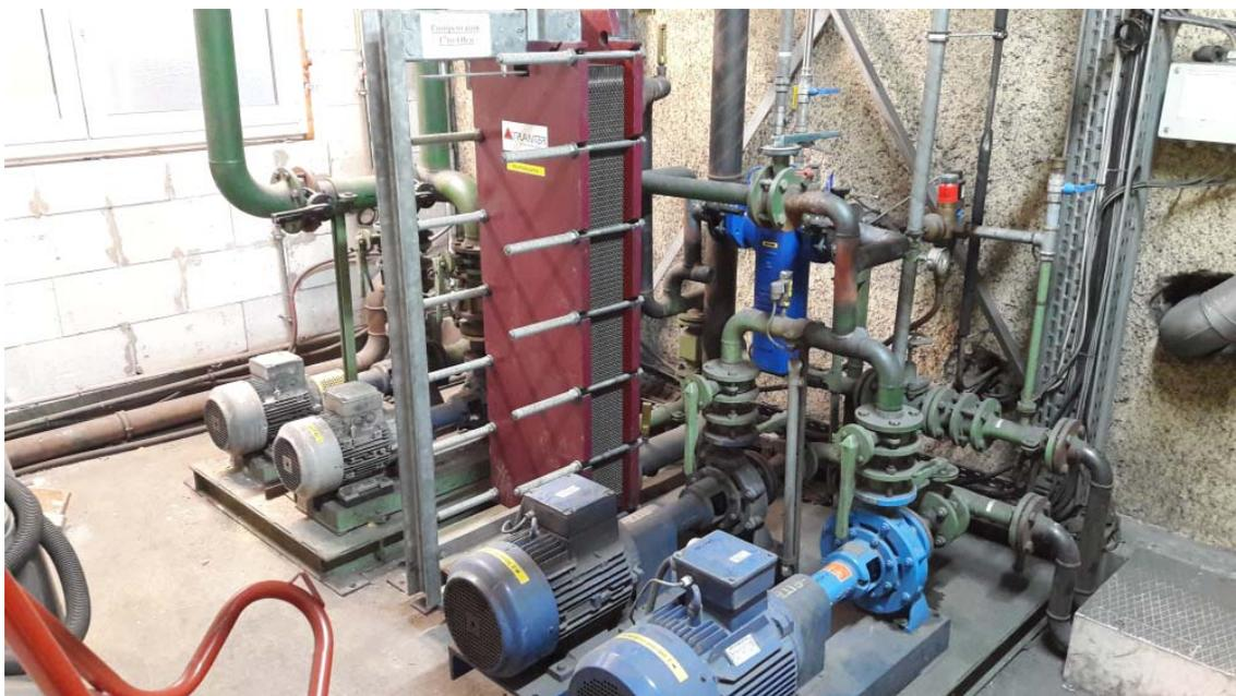
Abbildung 4: Wärmeübertrager zur Kühlung der Induktionsspule eines Schmelzofens mit Pfefferwasser (Foto: Solites)
