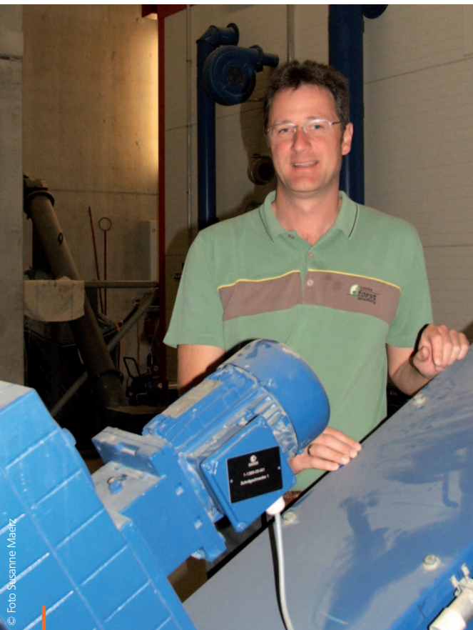
Die Genossenschaft Bürger Energie St. Peter hat die Wärmeversorgung ihres Ortes auf regenerative Energiequellen umgestellt; im Bild Vorstand Markus Bohnert in der genossenschaftlichen Heizzentrale.
